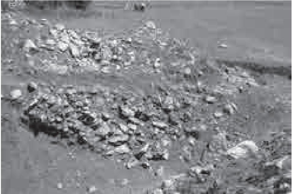
Resim 15: Mamba şevinin taş dolgusunun kesiti
