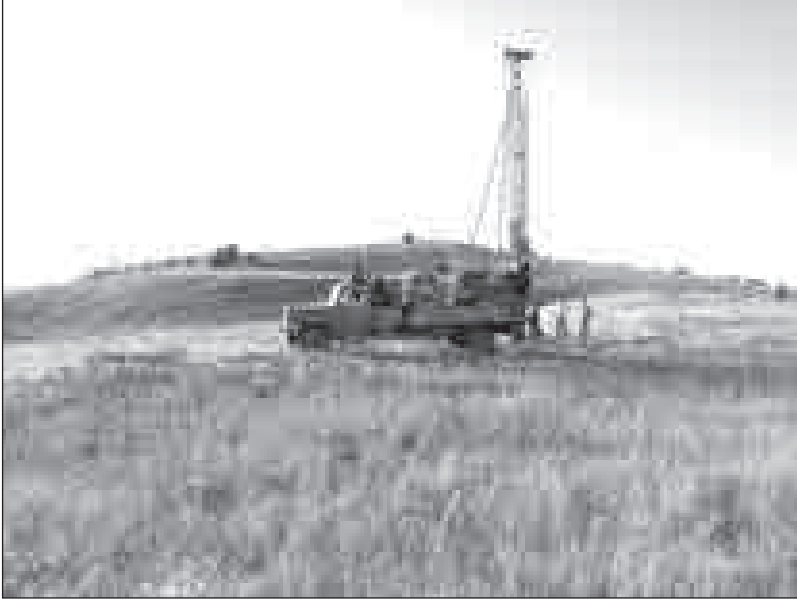
Resim 5: Güney Havuzlarda sondaj yapılırken
